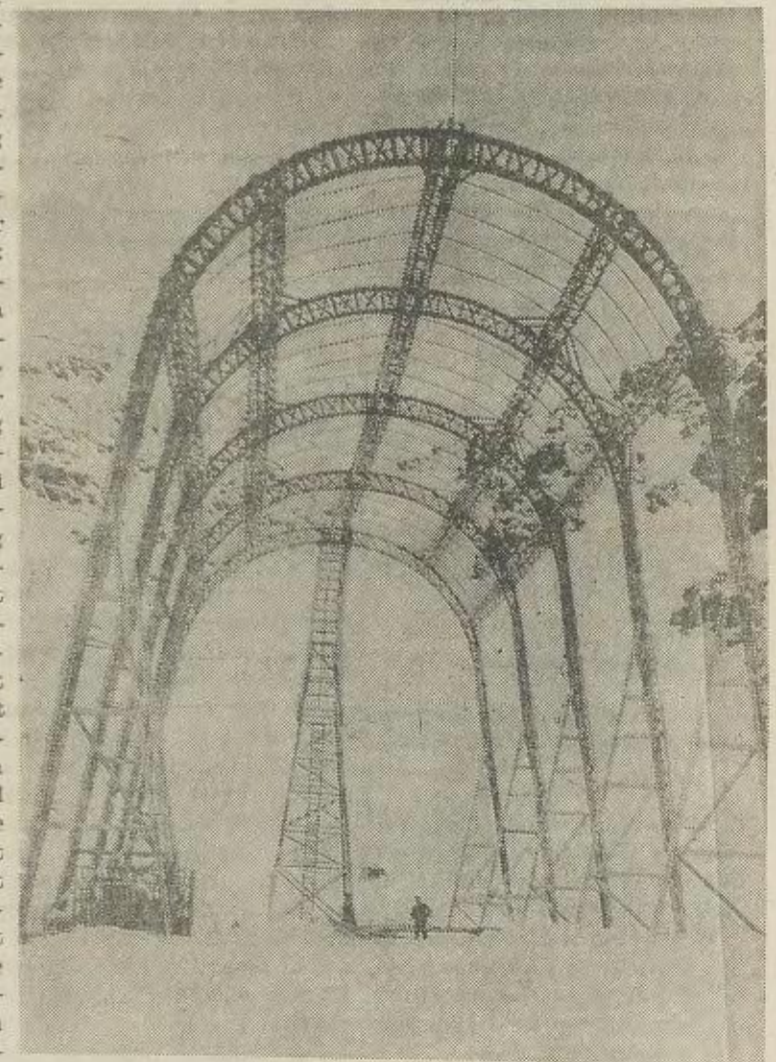
Et bilde av den første luftskipshallen som ble bygd i 1906. Den blåste ned om vinteren 1908 — 09.
